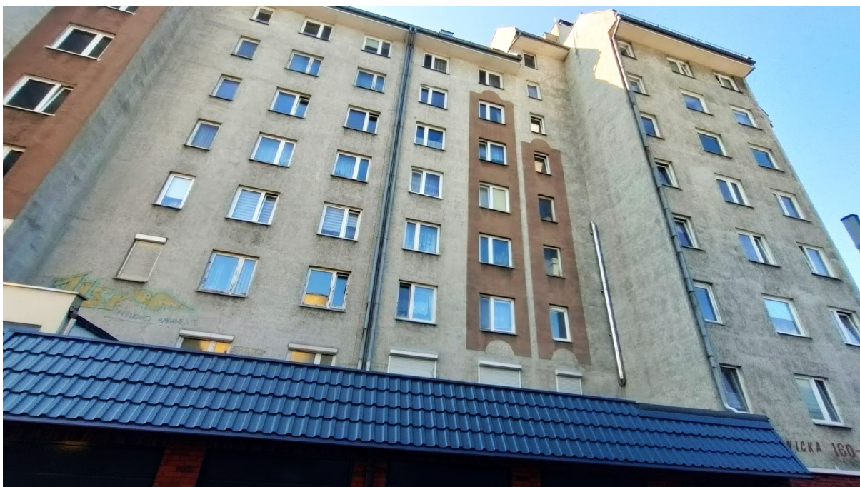
zdj. 3 – elewacja północna
