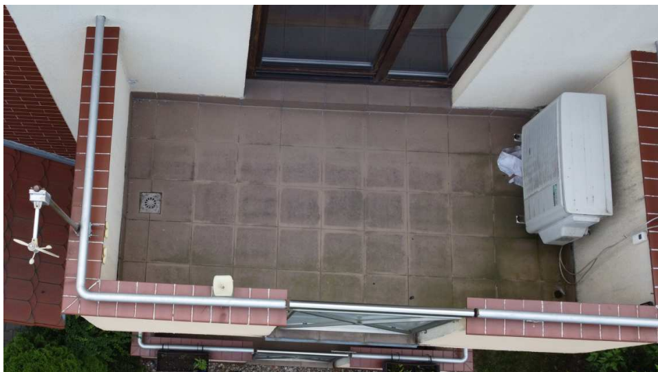
Fot. 3.1. Przykładowy balkon pierwszej kondygnacji – typ 1 (krótki)
