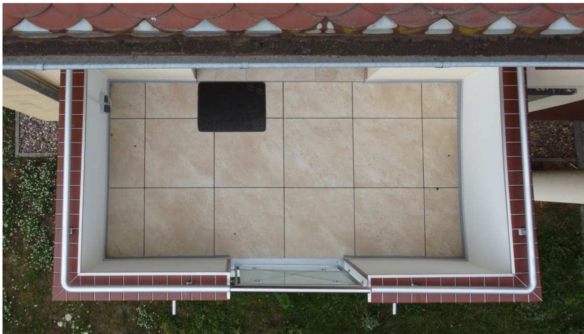
Fot. 3.3. Wyremontowany balkon pierwszej kondygnacji – klatka 32, w technologii posadzki pływającej
