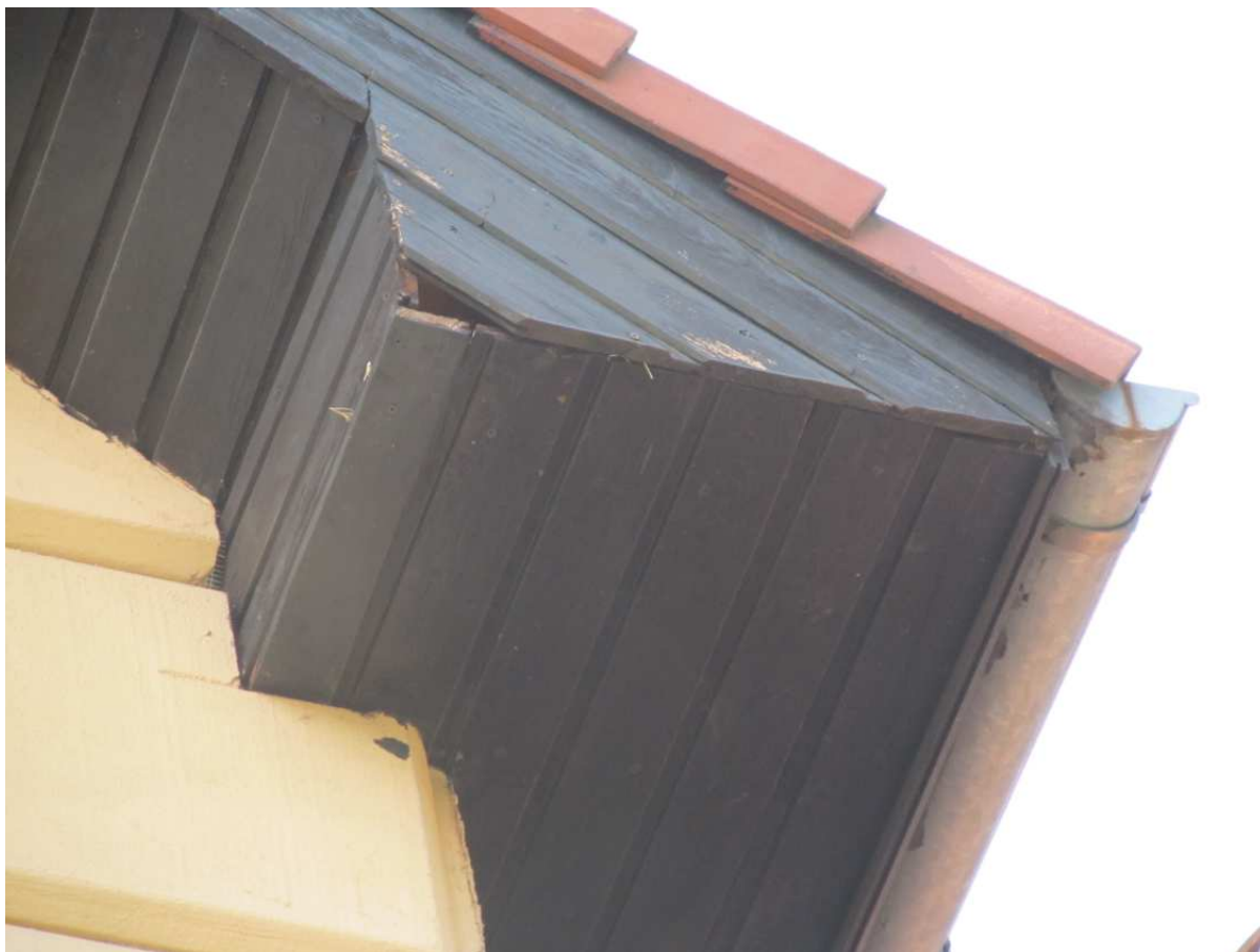
Fot. 11. Stwierdzono lokalne ubytki fragmentów deskowania na zadaszeniu nad klatką 34 – na połaci wschodniej
